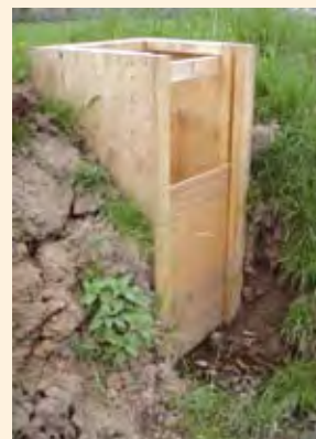
Foto links: Huidige situatie baggerdepot.
